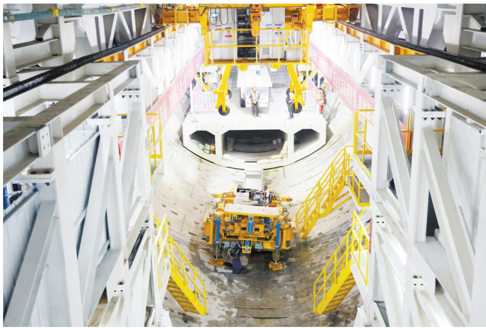
2024年2月16日，中铁十四局集团的建设者在京唐城际铁路运河湖隧道施工。
