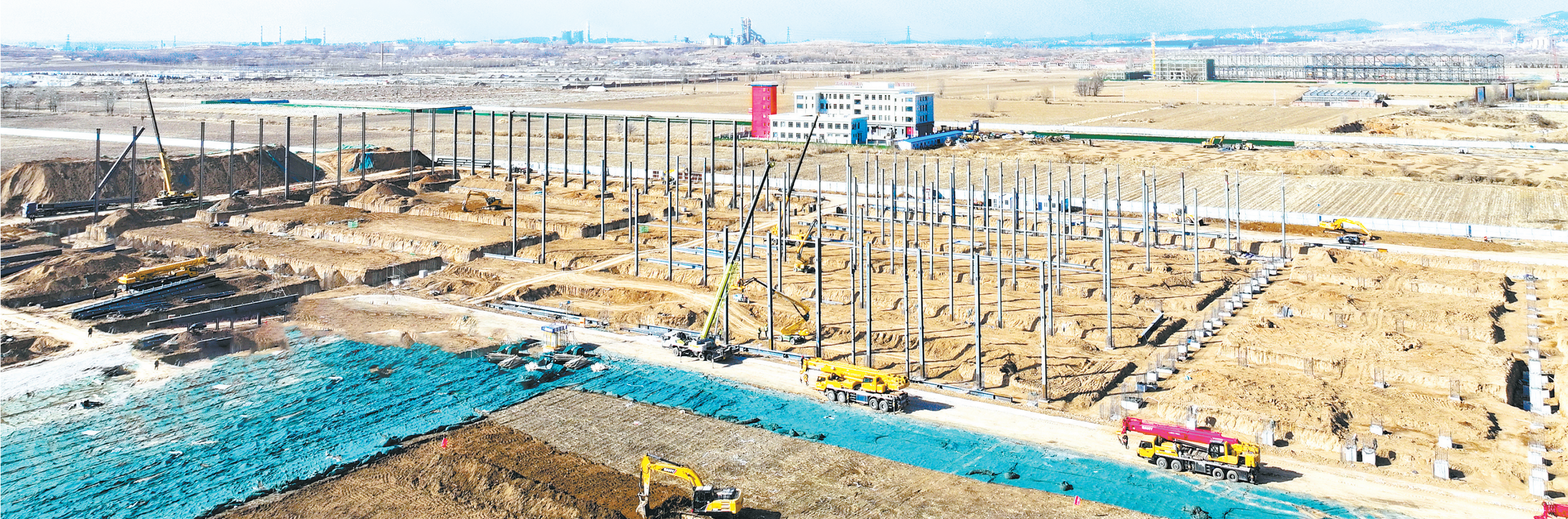
年产10万吨磷酸锰铁锂正极材料项目加快建设
