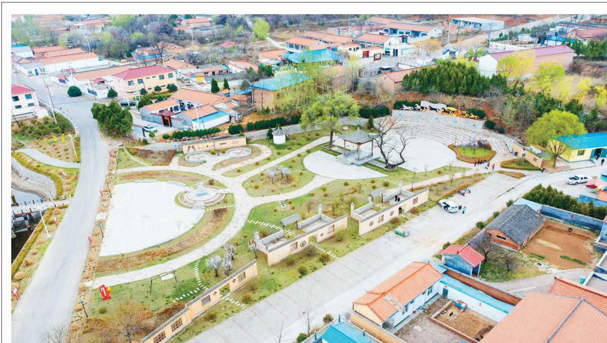
5月10日，航拍下的襄垣县夏店镇马喊村，村道整洁宽敞、房屋错落有致，一幅和谐宜居的美丽乡村画卷呈现眼前。近年来，马喊村大力开展农村人居环境整治，推动基础设施提档升级，村容村貌焕然一新。孙曼莎摄
