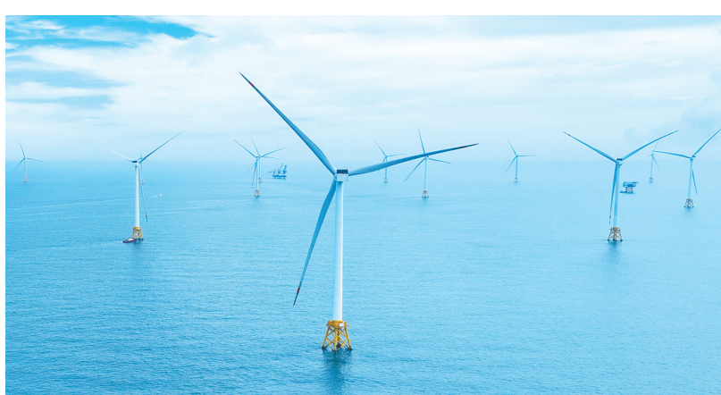
6月19日拍摄的三峡集团漳浦二期海上风电项目现场（无人机照片）。6月27日，全国首个超大单机容量的海上风电机组项目——三峡集团漳浦二期海上风电项目实现全容量并网发电。漳浦二期海上风电项目位于福建省漳浦县海域，距离海岸线约30公里，总装机容量达400兆瓦，是我国首个全部采用13兆瓦及以上超大单机容量风机的海上风电场，其中批量化应用了6台16兆瓦海上风电机组。
