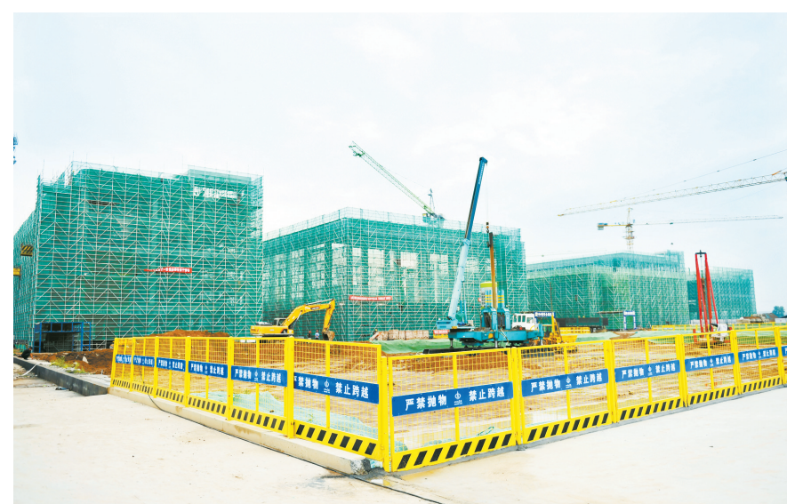
7月25日,高新区智能终端产业园PPP项目三期施工现场正在紧张建设中。该项目致力于打造以智能终端、电子信息、高端装备制造业为主的现代化、智慧化产业园,预计2024年年底完成所有主体封顶。 本报记者 董雷 摄
