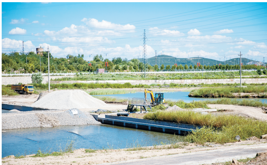
连日来，襄垣县浊漳南源水环境提升综合整治工程项目建设加快推进，预计9月底全部完工。该工程位于襄垣县西源河大桥东西两侧，浊漳河南源和西源交汇处。项目完工后，辖区水质将得到显著改善，水域生态系统服务功能将显著增强。 孙曼莎 摄
