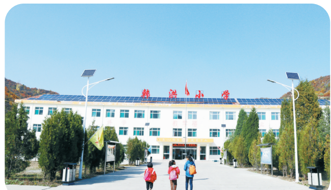
韩洪村韩洪小学光伏发电项目
