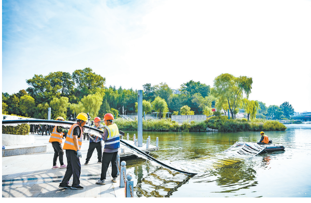
日前，“三河一渠”水质提升综合治理工程(太行公园段)施工现场，工人正在往石子河中安装MABR膜强化净化系统。我市“三河一渠”水质提升综合治理工程，规划新建6处MABR膜强化净化系统，面积共计5.95万平方米。 王嘉琦 摄
