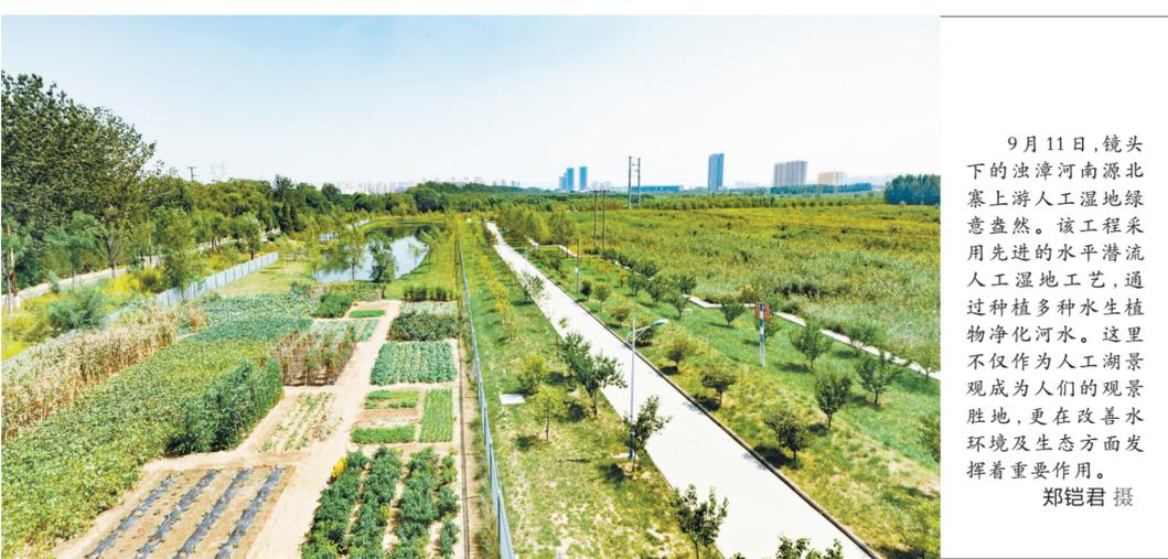
9月11日，镜头下的浊漳河南源北寨上游人工湿地绿意盎然。该工程采用先进的水平潜流人工湿地工艺，通过种植多种水生植物净化河水。这里不仅作为人工湖景观成为人们的观景胜地，更在改善水环境及生态方面发挥着重要作用。
