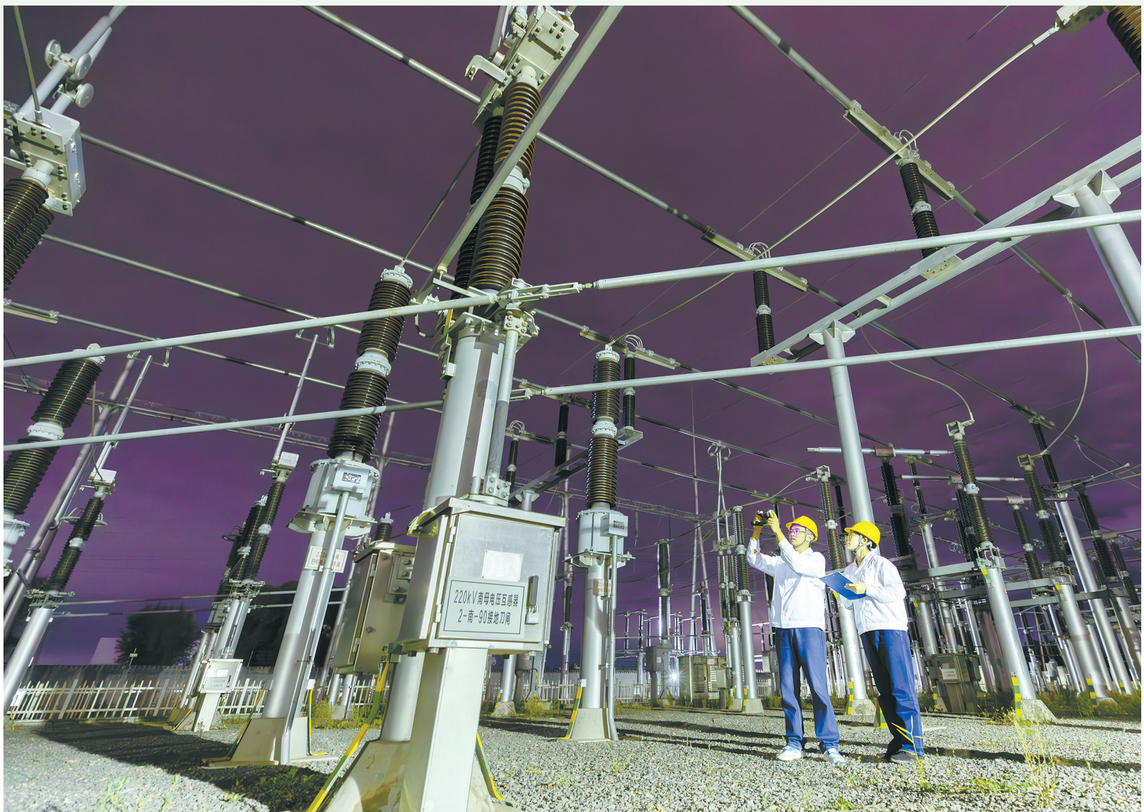
国网山西省电力公司长治供电公司工作人员开展设备巡视及红外测温,确保节假日设备安全稳定运行。
