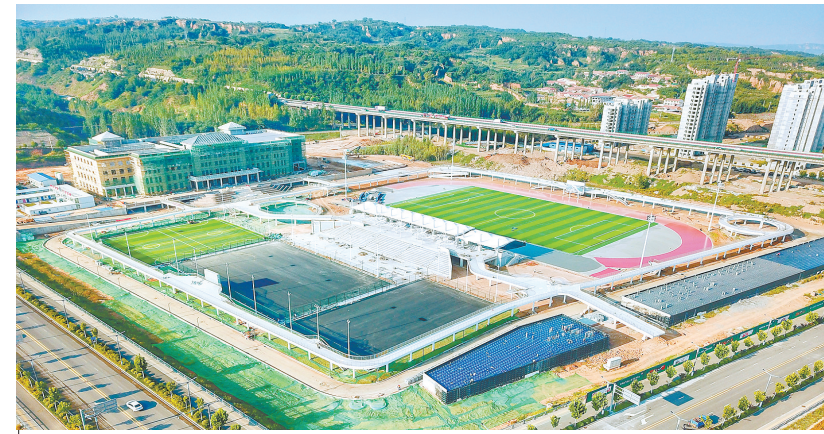
9月19日,武乡县全民健身综合服务中心项目正在加紧施工。该项目占地约5.4万平方米,集标准足球场、网球场、篮球场等于一体,项目建成后有效提升城市体育设施水平,进一步擦亮城市名片。李勇 摄
