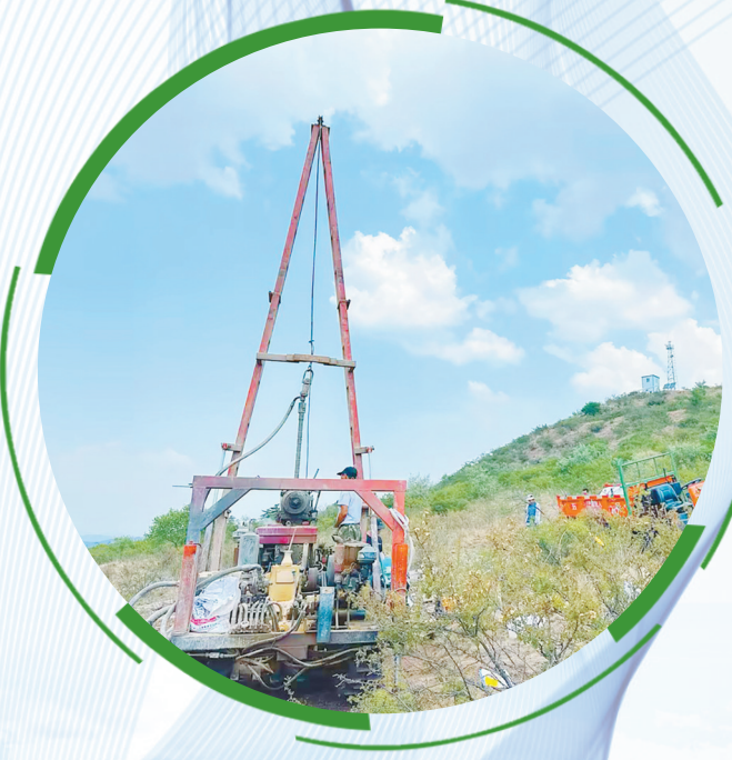
中电建沁源100兆瓦光伏项目加快推进
