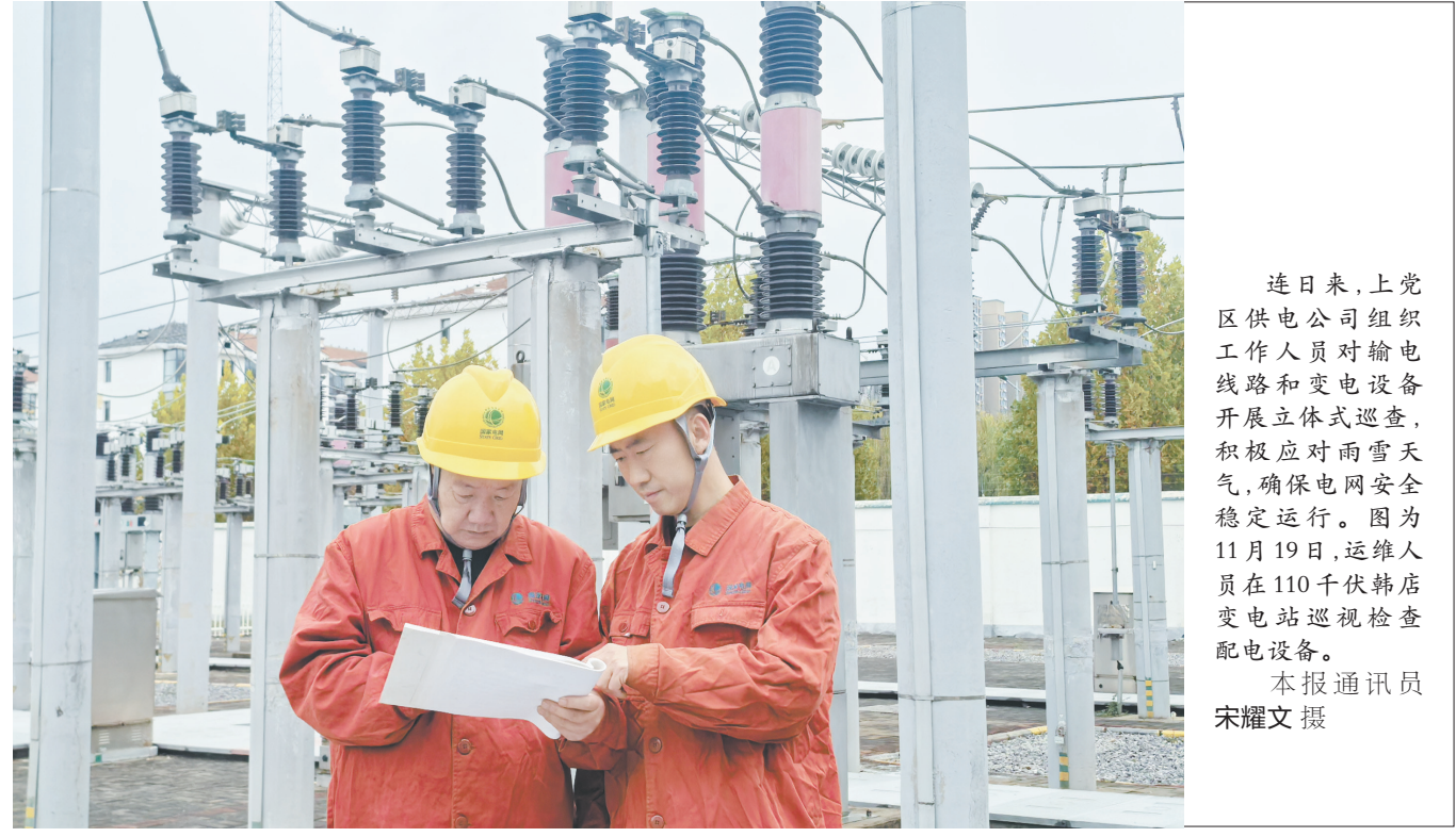
连日来,上党区供电公司组织工作人员对输电线路和变电设备开展立体式巡查,积极应对雨雪天气,确保电网安全稳定运行。图为11月19日,运维人员在110千伏韩店变电站巡视检查配电设备。 本报通讯员 宋耀文 摄
