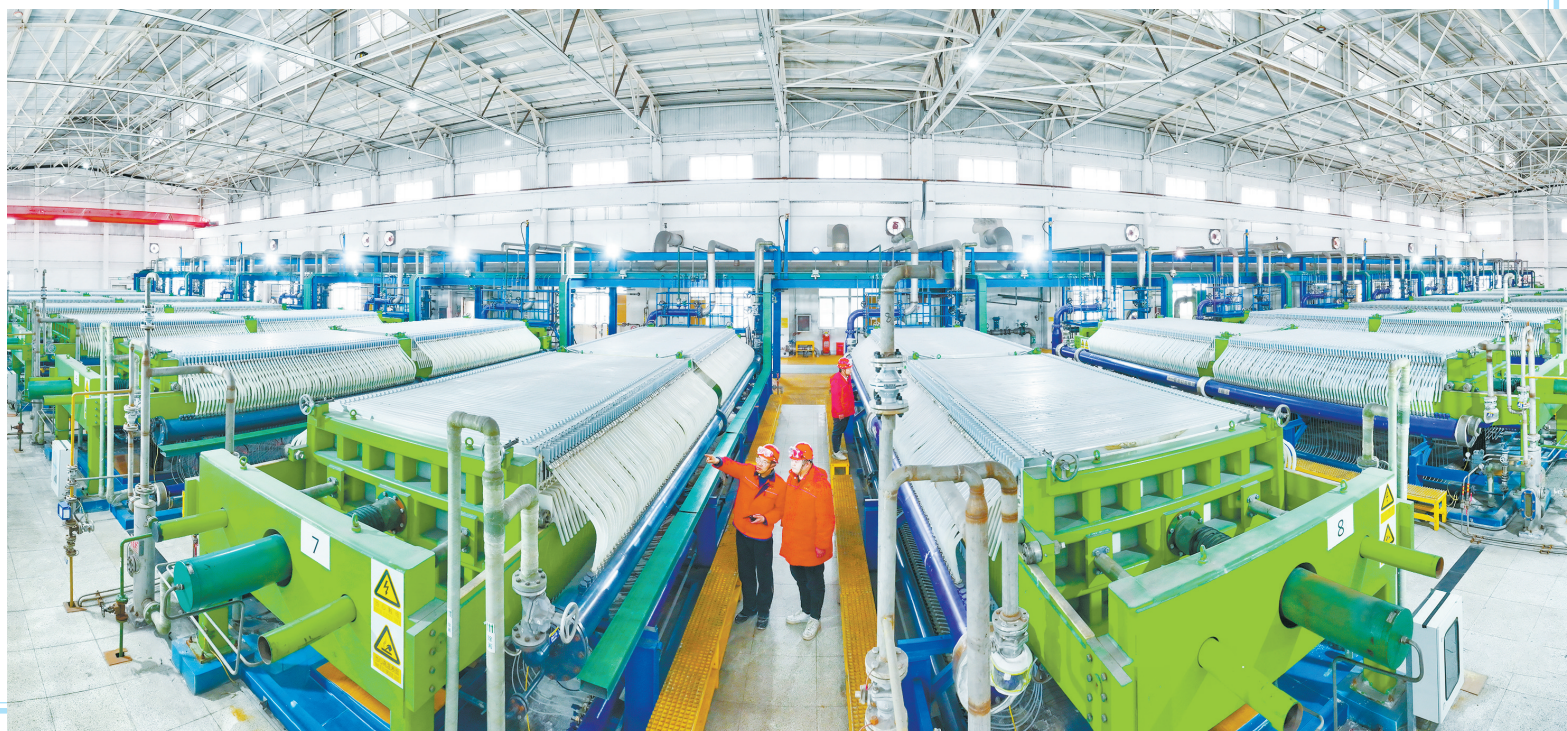
山西瑞恒化工有限公司电解车间技术人员监测设备运行
