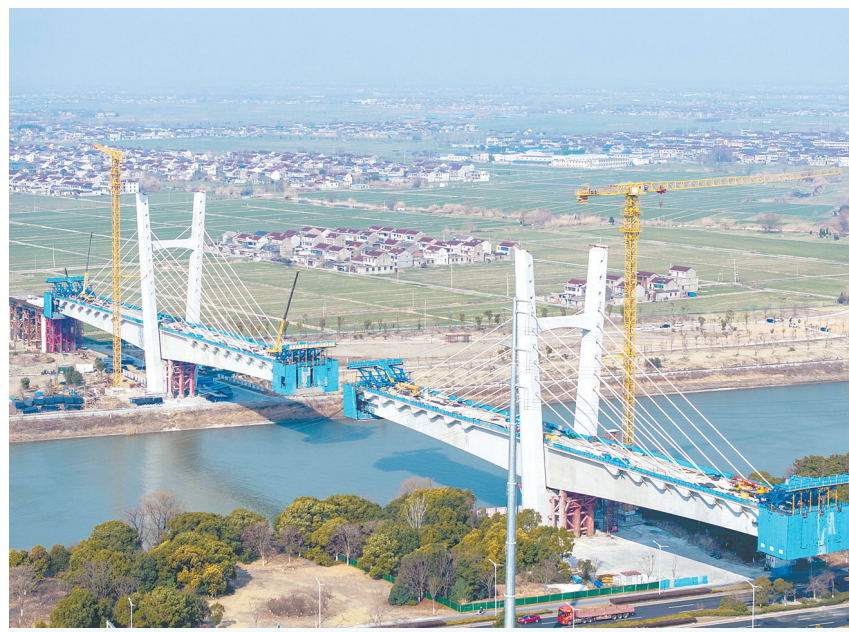
2月19日，工人在进行施工作业（无人机照片）。目前，沪渝蓉高铁泰州段全面进入箱梁架设阶段，箱梁架设设计于今年10月全部完成。沪渝蓉高铁线路总长约2100公里，全线设计时速350公里，是国家“八纵八横”高铁骨干通道之一。 新华社发（汤德宏 摄）
