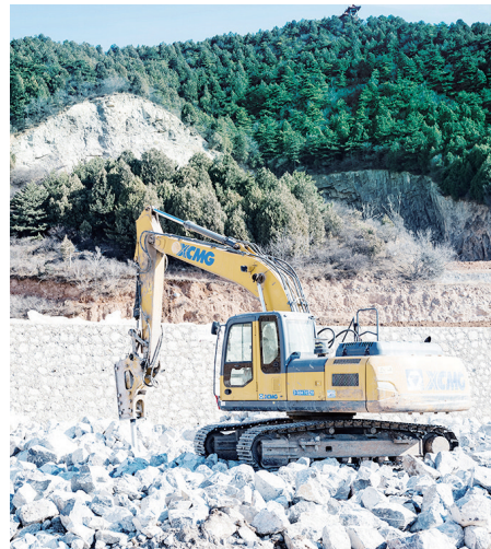
项目施工现场。(潞州区融媒体中心提供)
