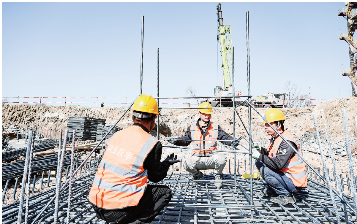
项目施工人员作业中。王嘉琦 摄
