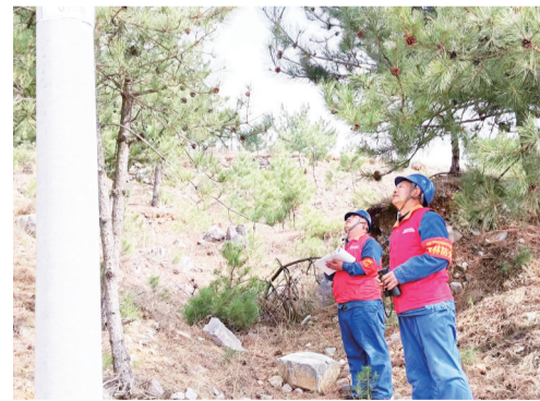
4月1日,平顺县玉峡关镇供电所针对春季森林防火安全,开展防火专项排查活动,确保线杆无裂纹、线路无破损、拉杆无松弛,为春季森林安全筑起“防火墙”。 杨开方 摄
