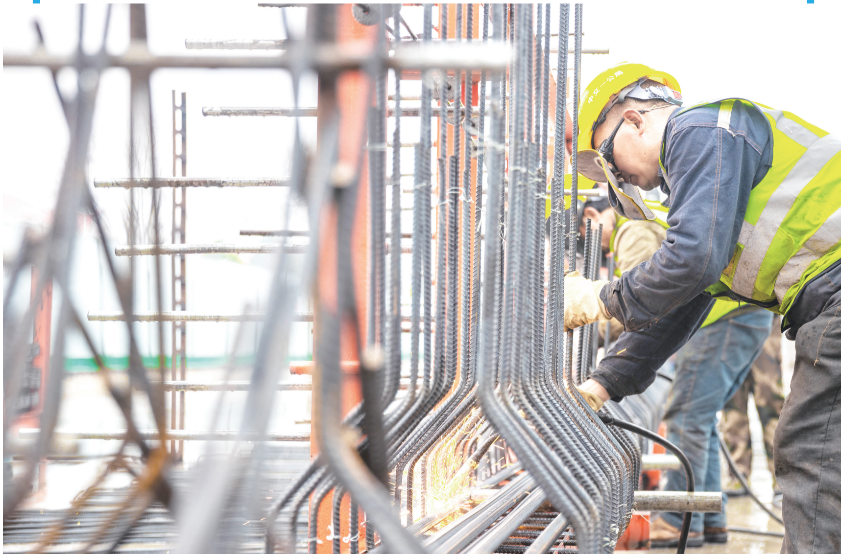
工人师傅们进行钢筋加工作业。
