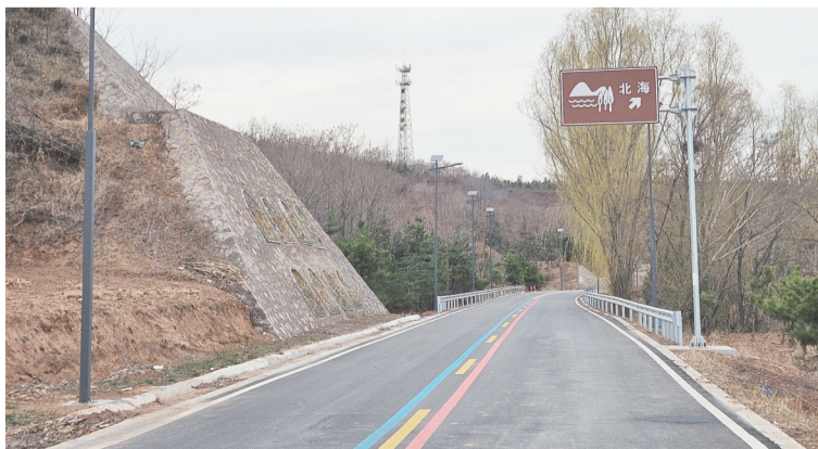
环湖旅游公路环北海段的路灯已安装完毕。
