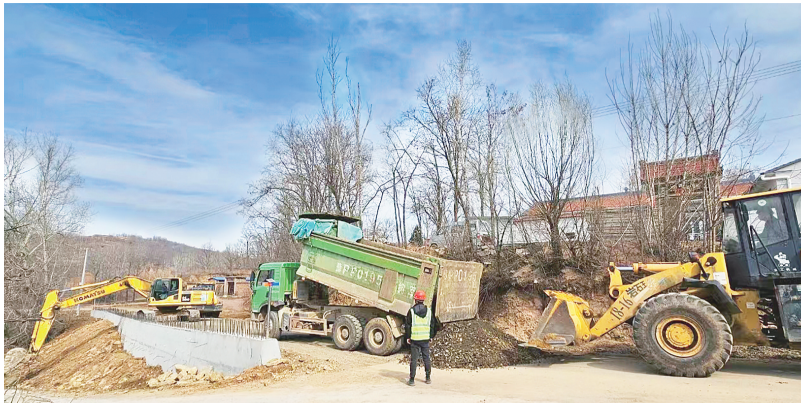
在环徐阳湖段涵洞工程、桥梁工程顺利推进。
