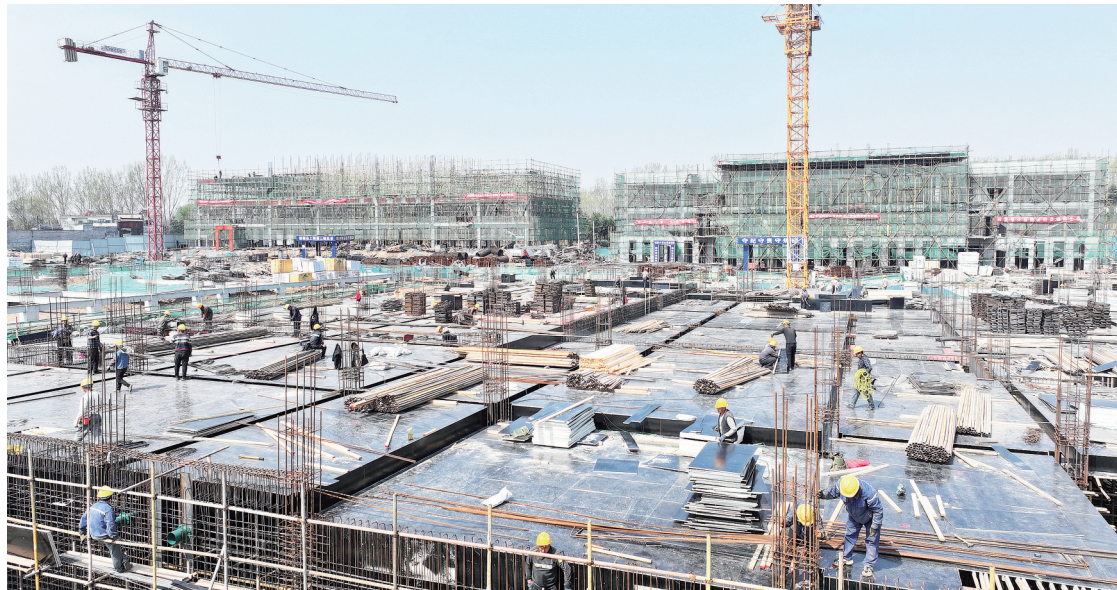
图为市产教融合实训基地项目建设施工现场。杨鹏 摄
