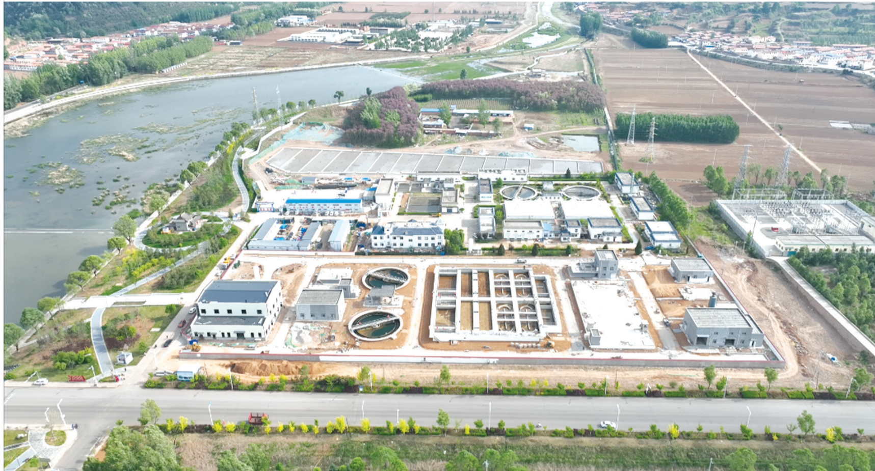
沁源县县城污水处理厂扩容改造工程是2024年实施的重点工程,目前正在有序推进。
