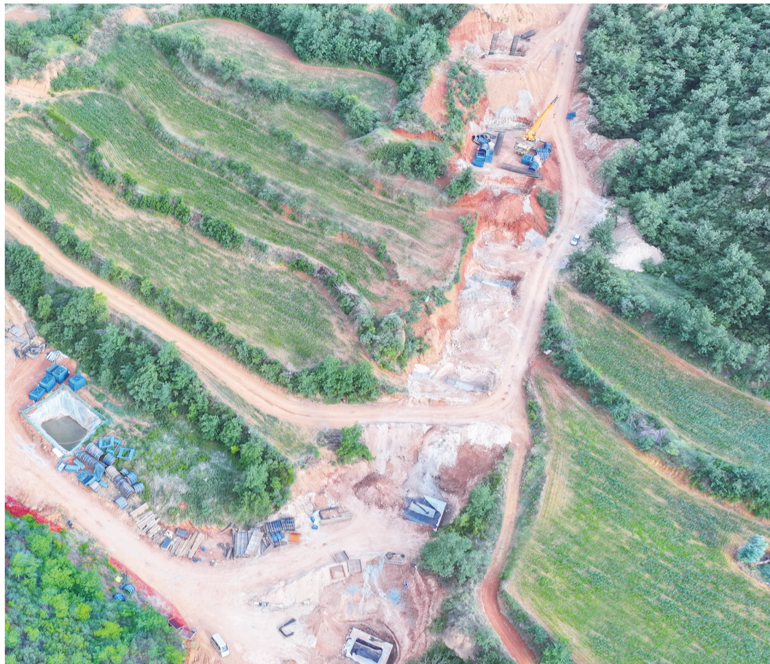
潞城区太行一号旅游公路施工现场。
