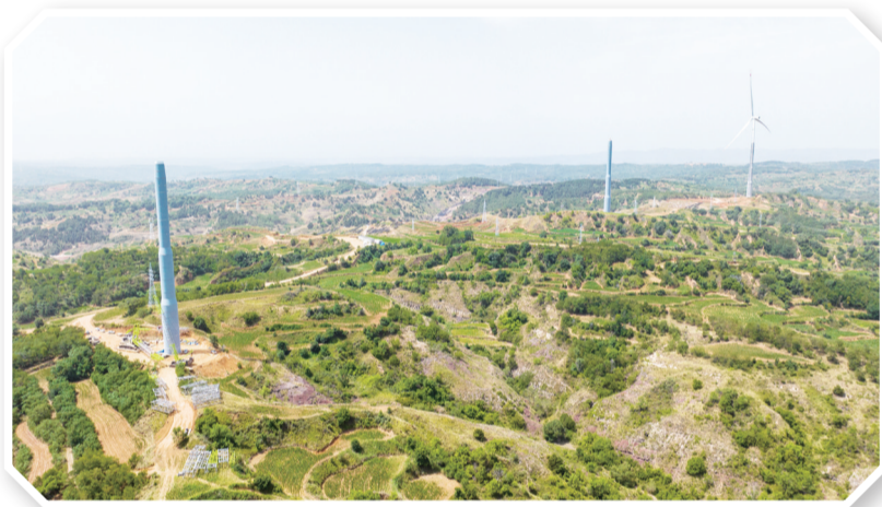
本版图片为襄垣县“风光储一体化”工程建设现场。
