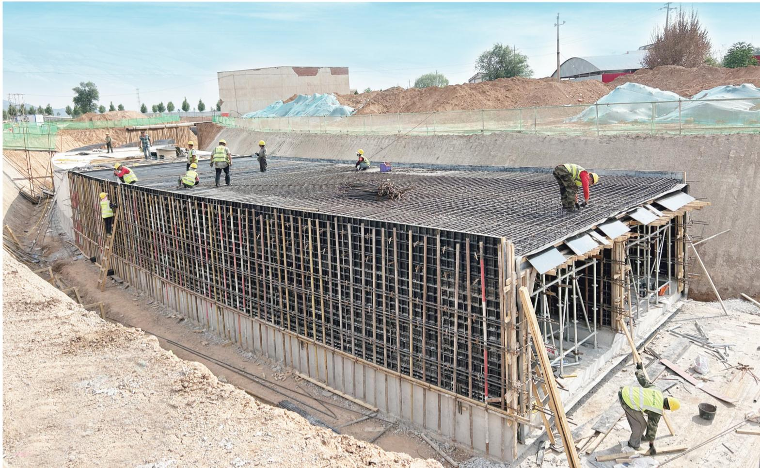
施工现场,工人们正在绑扎钢筋。
