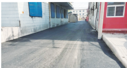
改造后的路面。
