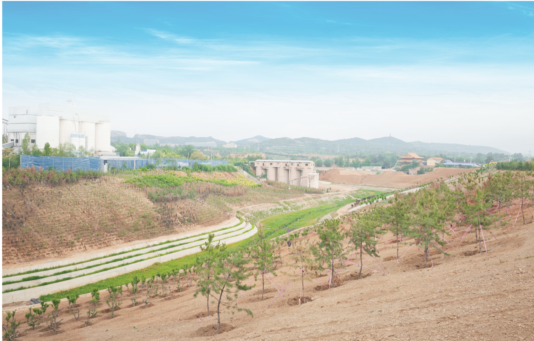
石子河潞州区段上游河道岸坡生态治理工程现场。冯毅松 摄
