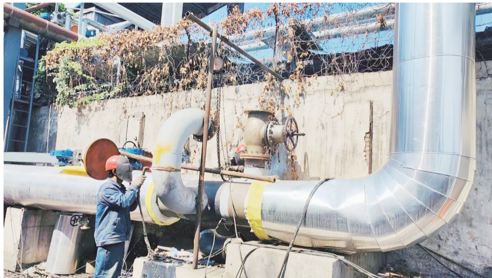
供暖队队员对供暖管道进行检修。
