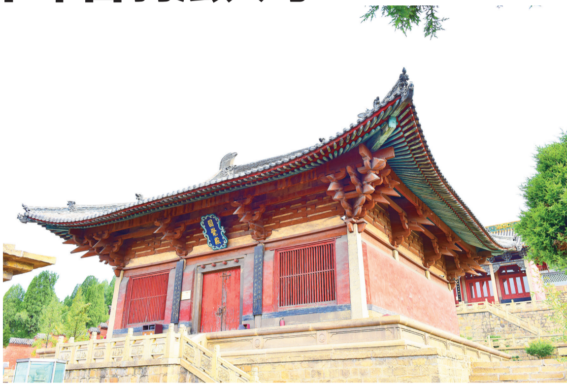
圆觉殿为本地区宋代三开间歇山顶木构建筑体量最大的一座。
