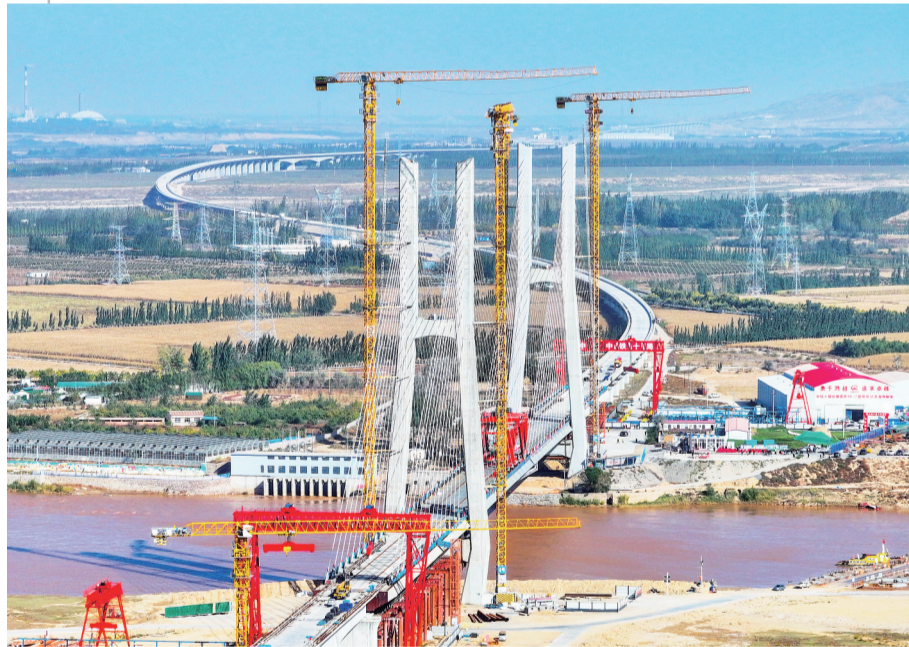
包银高铁乌海黄河特大桥合龙贯通
