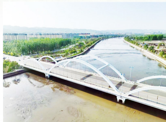
沁河南环大桥
