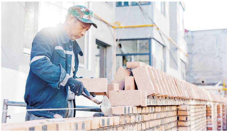
工人师傅正在施工。
