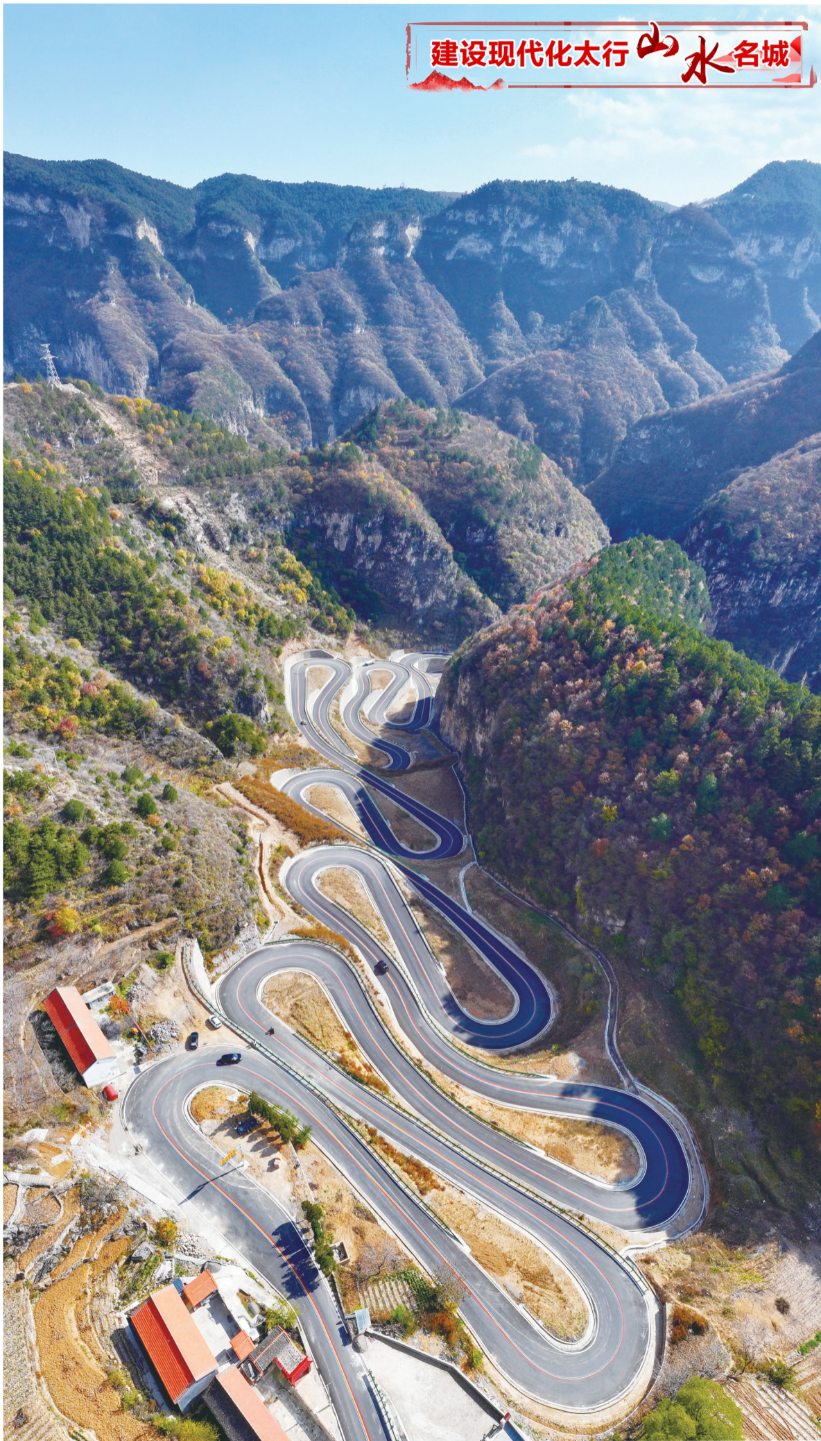
10月29日,在五彩斑斓的群山间,太行一号旅游公路壶关县东柏坡段宛如巨龙盘踞。这段约2.5公里的盘山公路,双向车道宽约7.5—10.5米,有众多回头弯和急转弯,上下落差达120米,形成“黑龙潭十六拐”景观。
