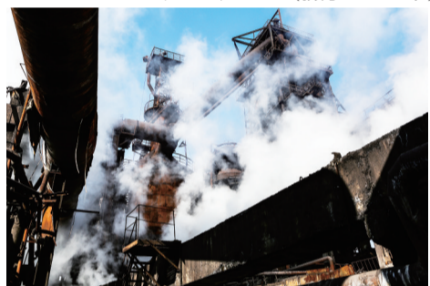
炼铁高炉正在生产。(摄于2012年)
