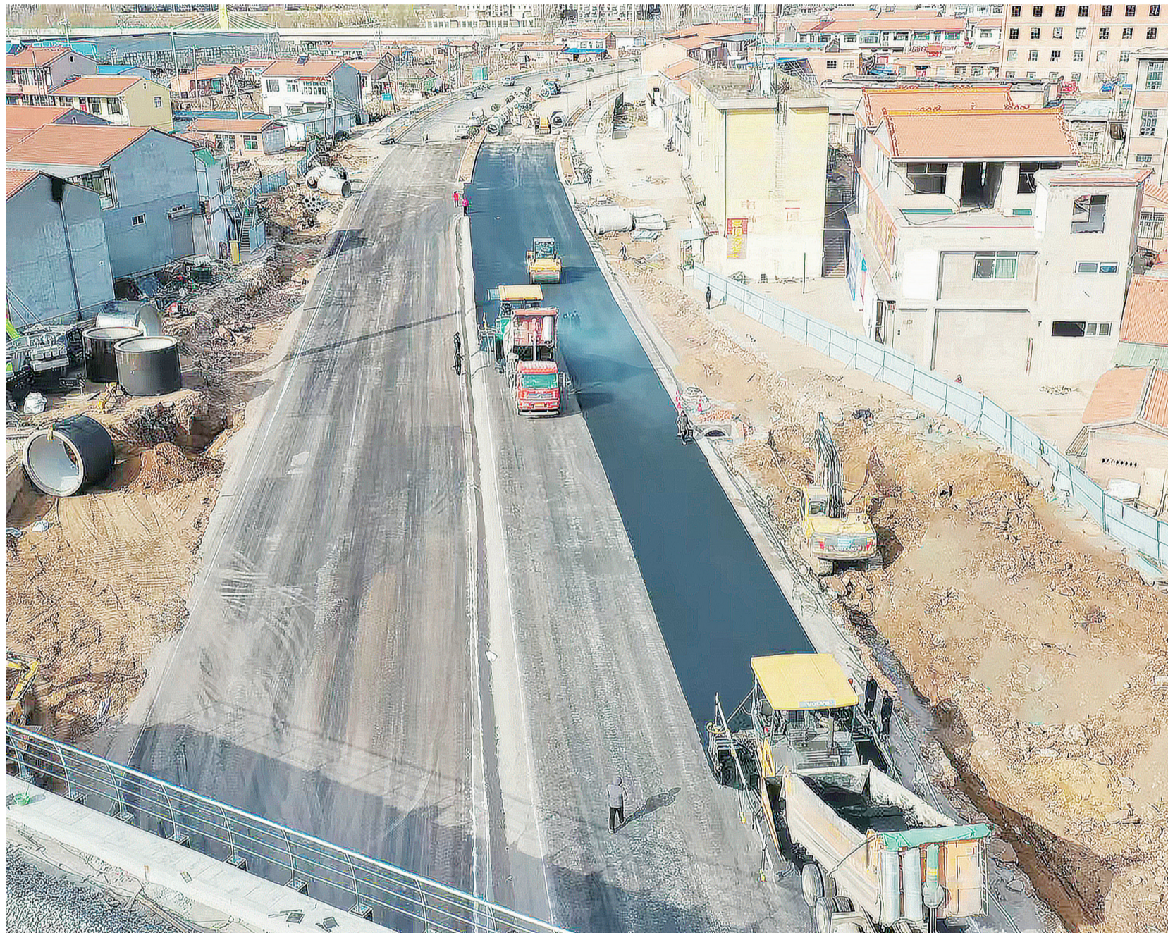
随着最后一段沥青上面层铺设,太焦高铁连接线沁县县城连接线实现主线贯通。 李旭豪 摄
