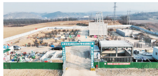
沁源北220千伏变电站项目建设现场。
