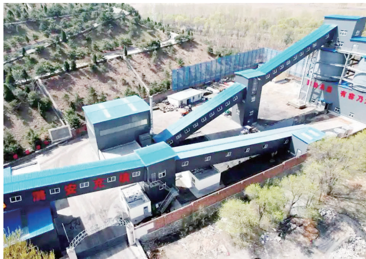
潞安工程有限公司矿井充填分公司常村充填站外景。
