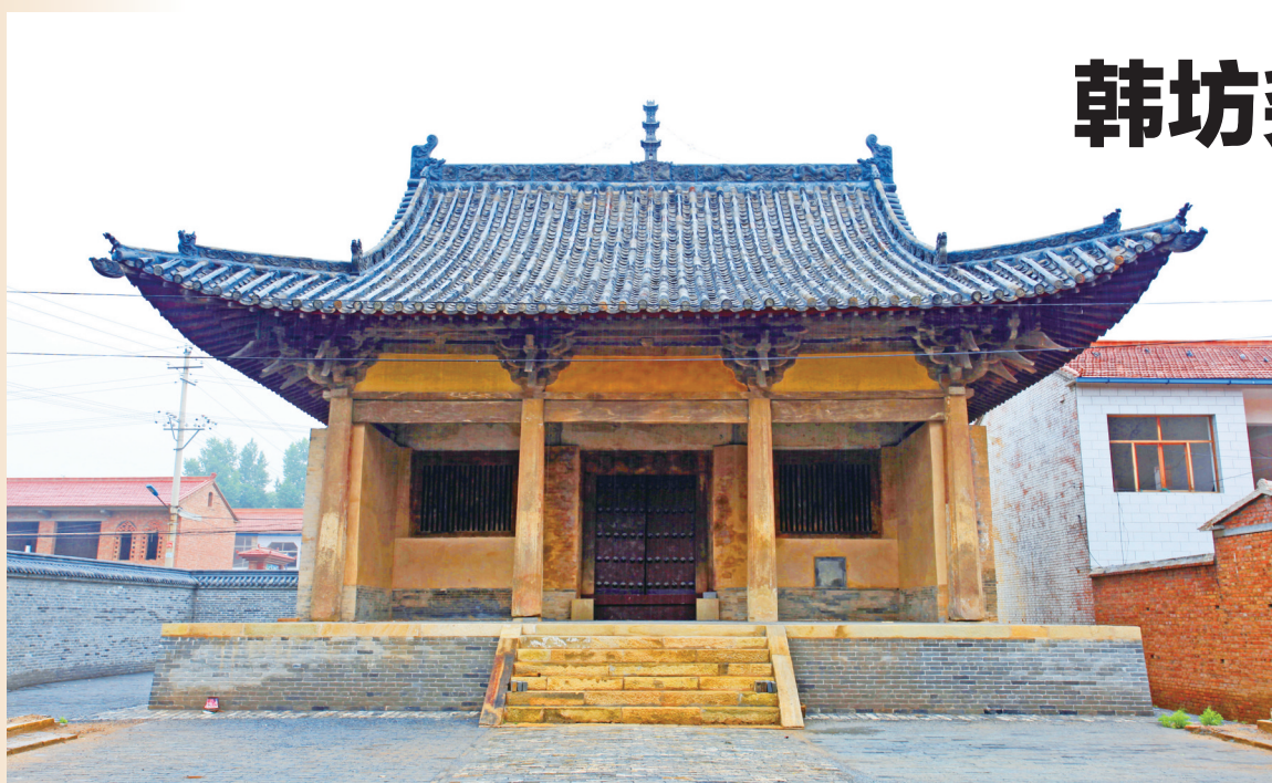
韩坊尧王庙大殿正殿(金)
