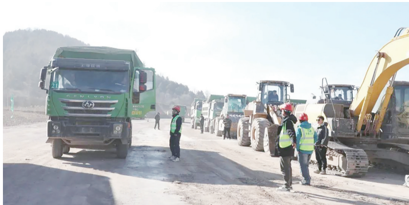
国道208项目(沁县段)改扩建工程复工现场。
