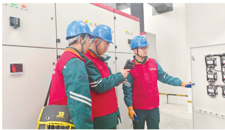
供电服务人员仔细检查校园内的电力设施。本报记者 马嫣婕 摄
