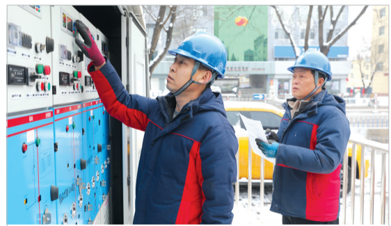
连日来,国网党区供电公司运维人员加强对重点地区、重点地段、重点设施、特殊时段的巡视、检查,做到安全隐患早发现、早预防、早制止、早处理,确保春季供电安全。 宋耀文 摄
