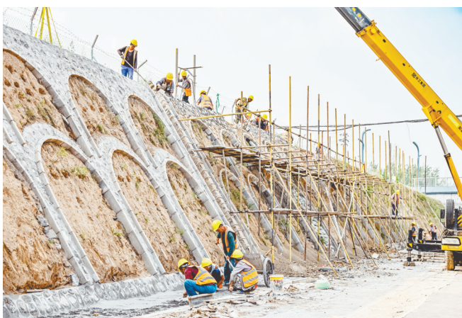
7月16日,潞州区东外环东关桥路段,施工人员对道路两侧护坡进行加固施工。连日来,我市持续推进护坡加固工程建设,确保群众安全度汛。 本报记者 司敏 摄
