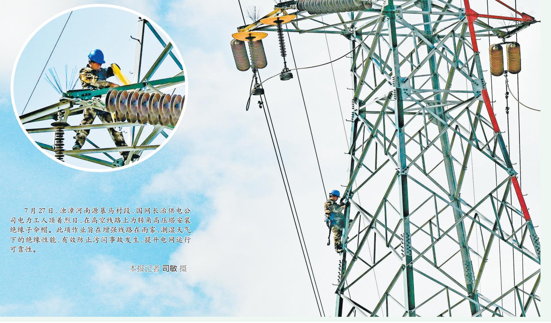
7月27日，浊漳河南源暴马村段，国网长治供电公司电力工人顶着烈日，在高空线路上为转角高压塔安装绝缘子伞帽。此项作业旨在增强线路在雨雾、潮湿天气下的绝缘性能，有效防止污闪事故发生，提升电网运行可靠性。
