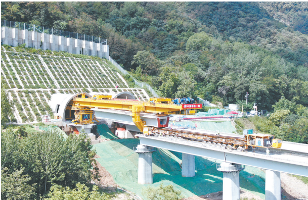
7月28日,施工人员在西康高铁跨关中环线立交特大桥架设全线最后一孔箱梁。 穿越秦岭山脉的西康高铁,新建正线全长171公里,设计时速350公里。建成通车后将大幅缩短关中城市群与陕南秦巴山区的时空距离,方便沿线居民出行,对陕南秦巴山区乡村振兴具有重要意义。 新华社记者 李一博 摄
