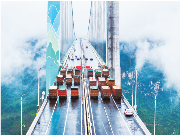
8月21日拍摄的贵州花江峡谷大桥荷载试验现场(无人机照片)。 8月21日，在建世界第一高桥——贵州花江峡谷大桥正式启动荷载试验。2022年开工建设的花江峡谷大桥，跨越被誉为“地球裂缝”的花江大峡谷，是贵州省六枝至安龙高速公路的控制性工程。大桥为钢桁梁悬索桥，全长2890米，其中主桥跨径1420米，桥面至水面高度625米。 新华社记者 杨文斌 摄
