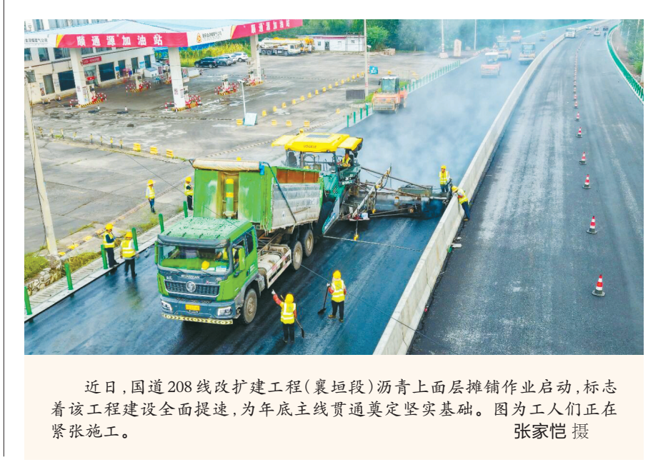
近日,国道208线改扩建工程(襄垣段)沥青上面层摊铺作业启动,标志着该工程建设全面提速,为年底主线贯通奠定坚实基础。图为工人们正在紧张施工。 张家恺 摄
