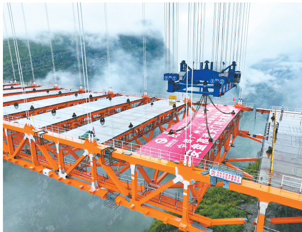
这是9月23日拍摄的天门特大桥（无人机照片）。9月23日，由中铁广州局等单位承建的贵州安（安顺）盘（盘州）高速天门特大桥成功合龙。天门特大桥是安顺至盘州高速公路的重要控制性工程，大桥全长1553米，桥面距离峡谷水面约560米。
