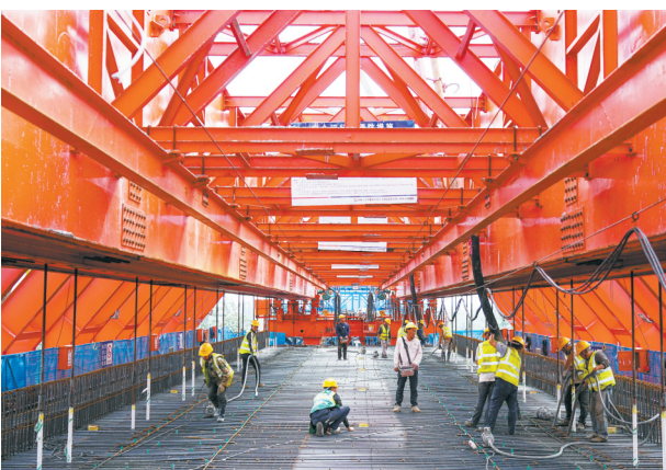
9月24日，国家重点项目潍（坊）宿（迁）高速铁路山东段安丘汶河特大桥十幅40米简支梁全部浇筑完成，项目承建方抢抓工期与节点，稳步推进标段施工。 新华社记者 朱峰 摄
