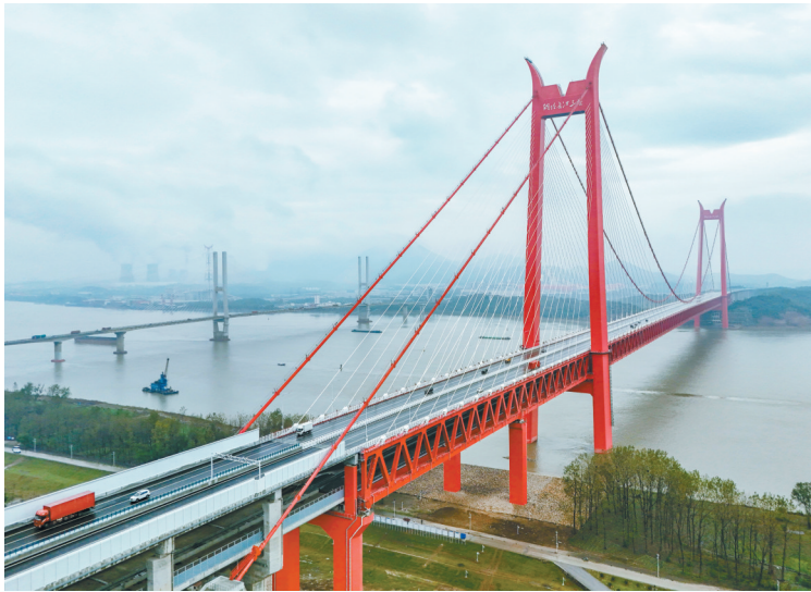
11月6日,车辆行驶在正式通车的铜陵长江三桥上(无人机照片)。 11月6日,由中铁大桥局施工的铜陵长江三桥正式通车。该桥是我国首座双层斜拉—悬索协作体系大桥,路线全长11.9公里,具有高速公路、城际铁路、货运铁路三种过江功能。 新华社发(储著传 摄)
