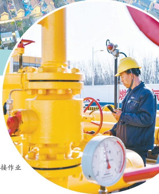
利用安全管理系统开展日常巡检及人工泄漏检测
