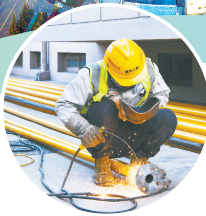
对老旧改造项目进行架空管法兰焊接作业
