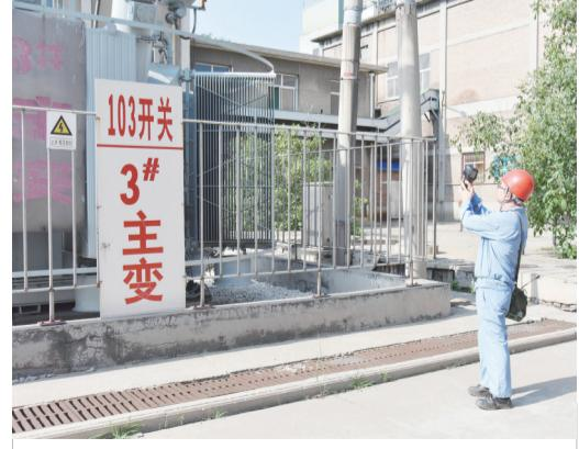
连日来,潞安化工天脊集团持续推进“排查身边隐患”活动,及时发现安全隐患,并精准处置,确保生产装置安全度夏、稳定运行。图为工作人员正在对供电设备进行测温检查。
